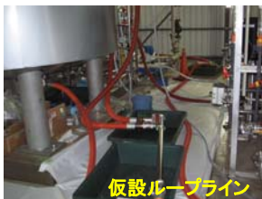
仮設ループライン
